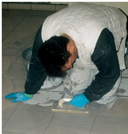
Abb. 3 Anwendung adäquater Hautschutzmaßnahmen: Fliesenleger.
