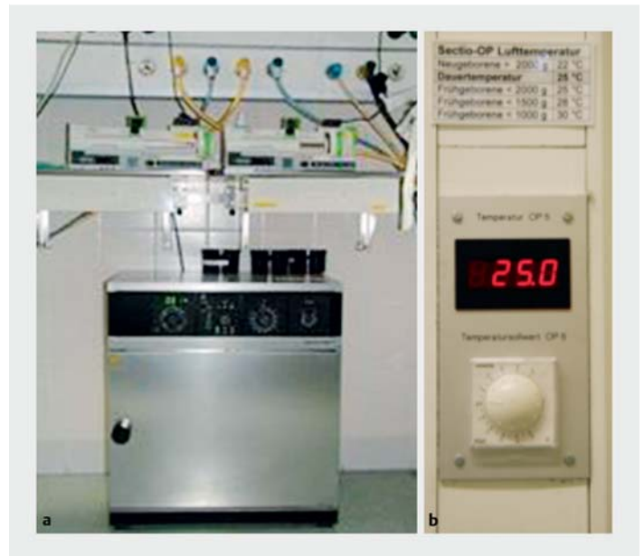
► Abb. 7 Wärmemanagement im Kreißsaal des Perinatalzentrums Magdeburg. a Wärmeschrank für vorgewärmte Windeln im Erstversorgungsbereich. b Thermostat zur Regulierung der Lufttemperatur im Sectio-OP.
