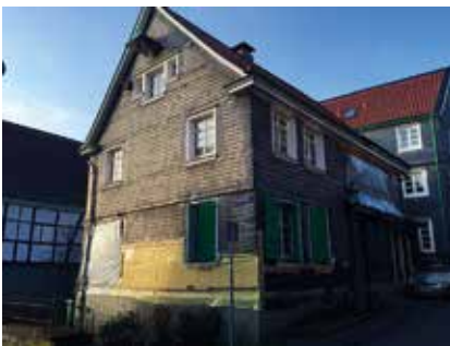
Die Baustelle des Röntgen-Geburtshauses in Remscheid-Lennep.
