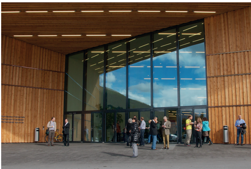
Das neue Kongresszentrum Davos, Eingangsbereich.
