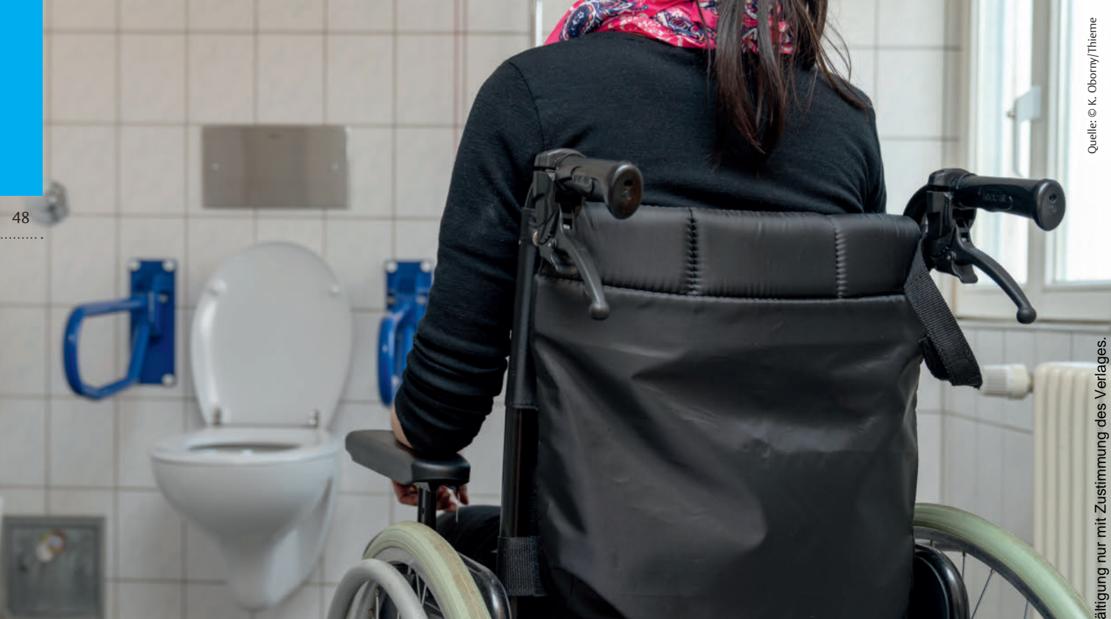
Sanitäreinrichtungen mit Griffen und ausreichendem Platz für Rollstühle gehören zum A und O der Barrierefreiheit.
